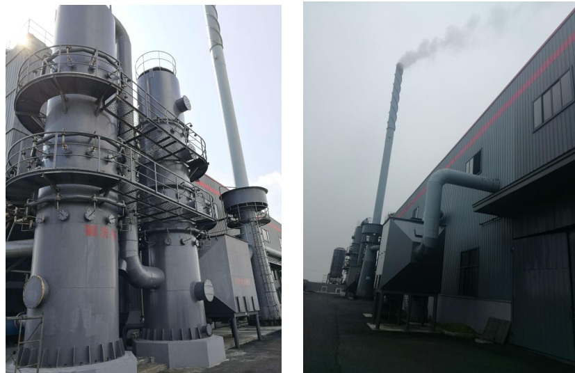
图 1-1 活化炉烟气处理装置
