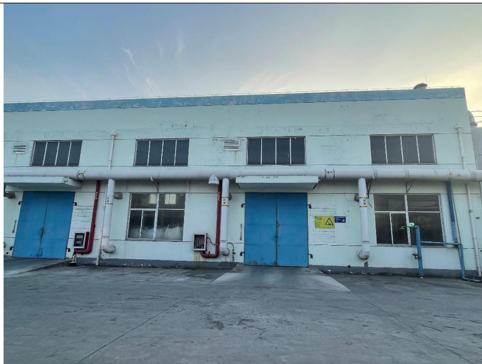
危废库外观及废气收集管线
