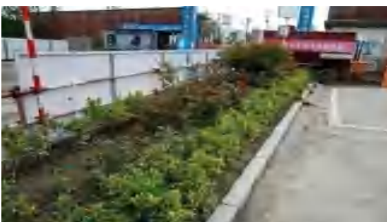
施工场地临时绿化 (2020.05)
