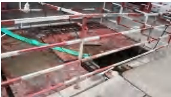
西北角出入口沉砂池 (2020.05)
