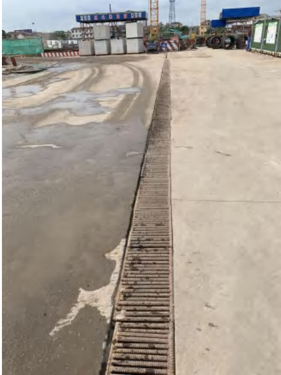
图1 项目临时排水沟
