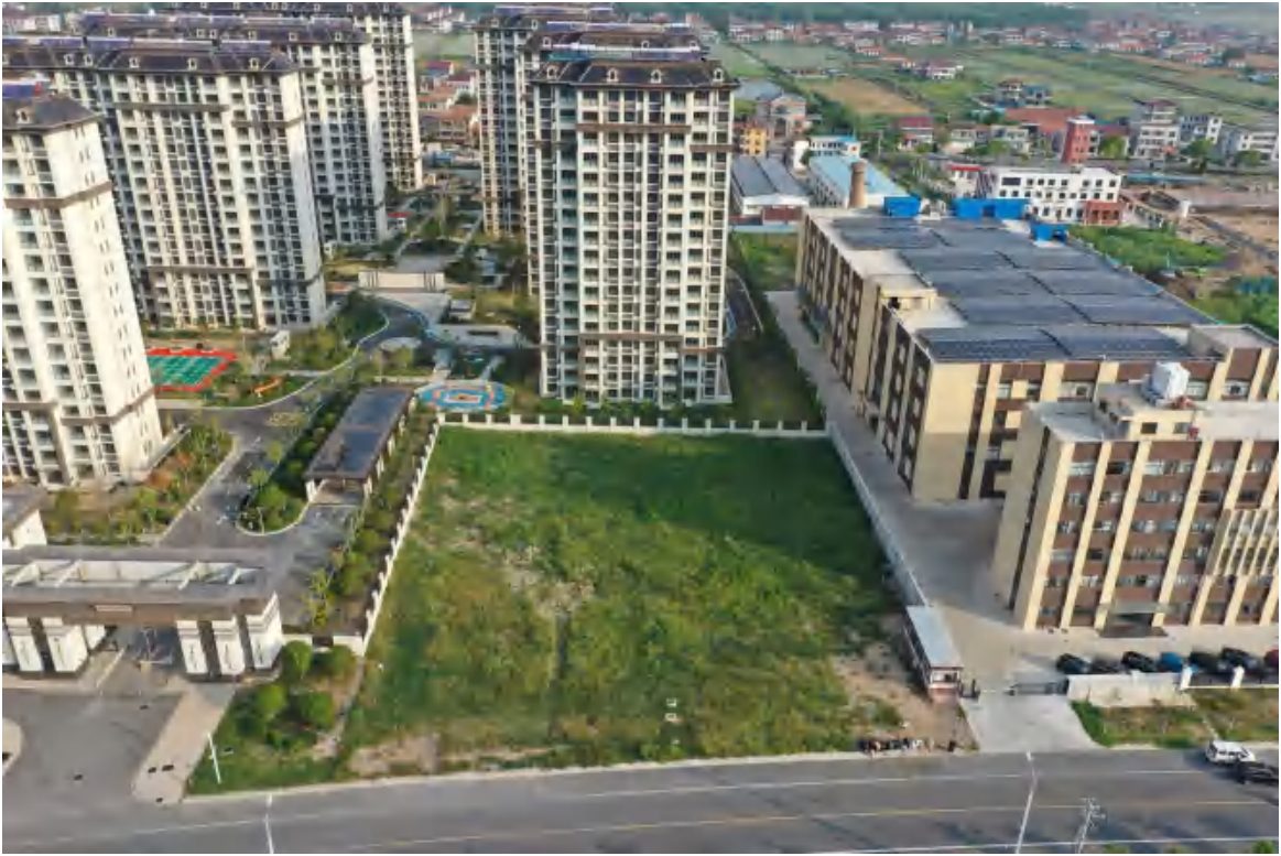
图1 项目施工生产生活区现状
