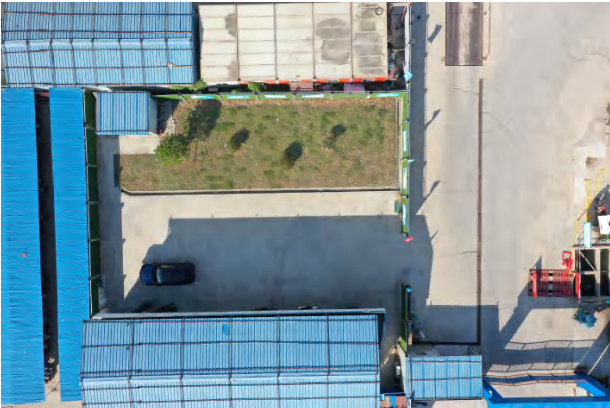
图3 项目施工生产生活区临时绿化
