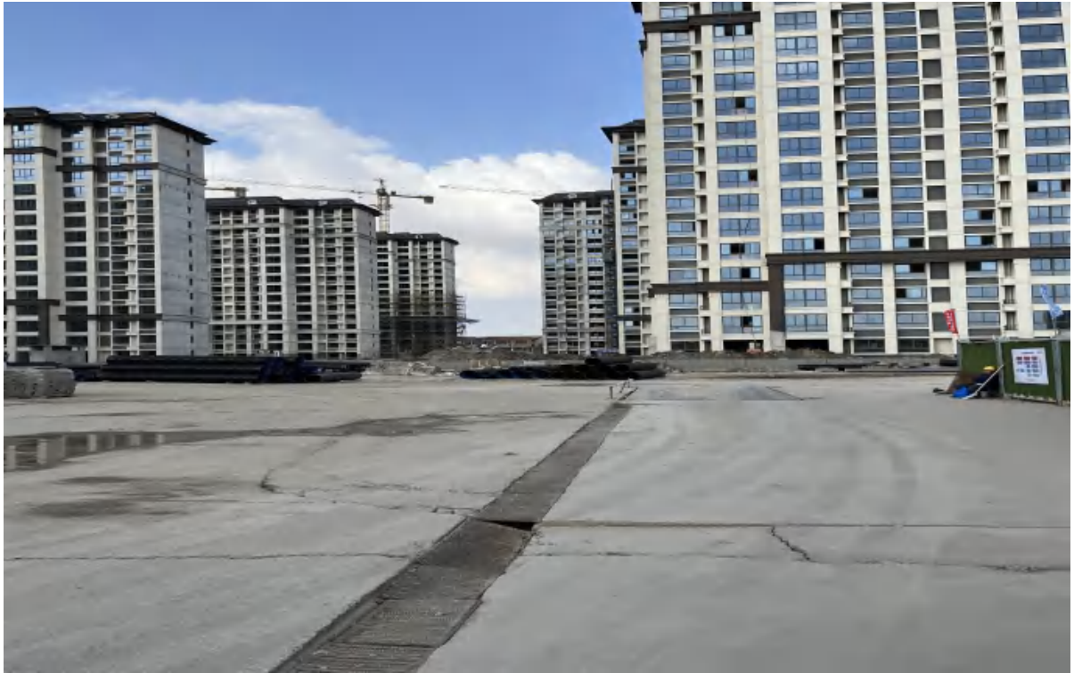
图1 项目场地硬化及临时排水沟
