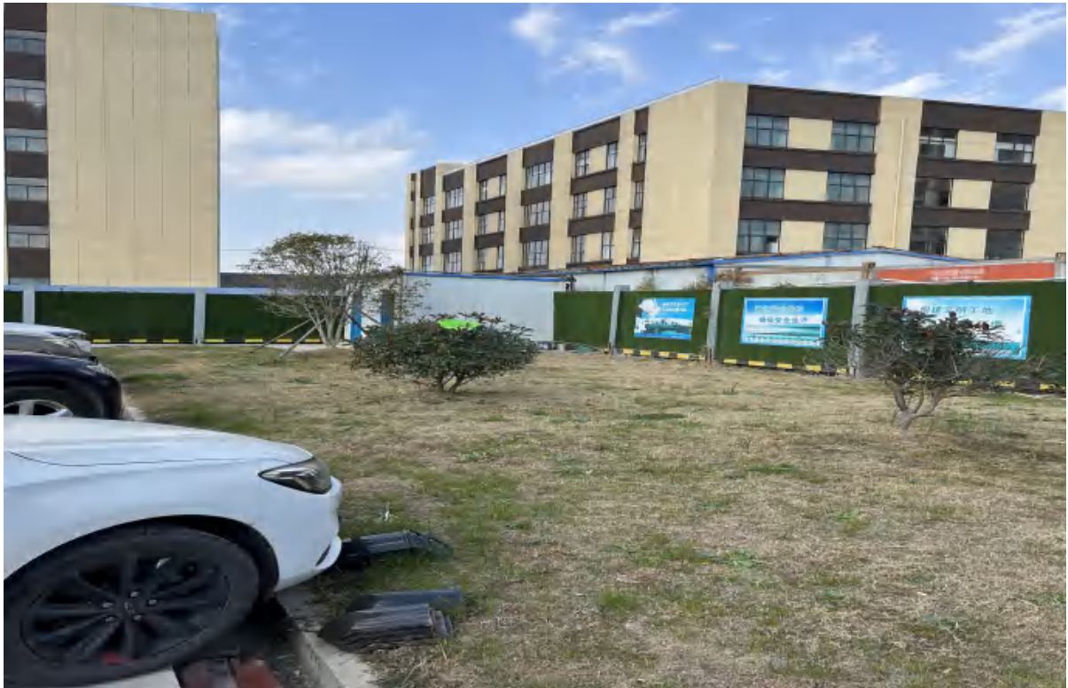
图3 项目施工生产生活区临时绿化
