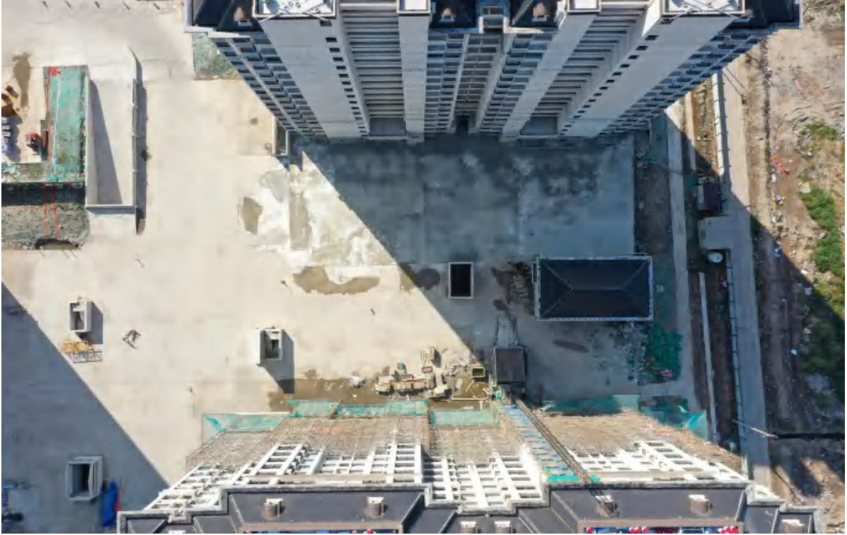
图1 项目场地硬化及临时苫盖
