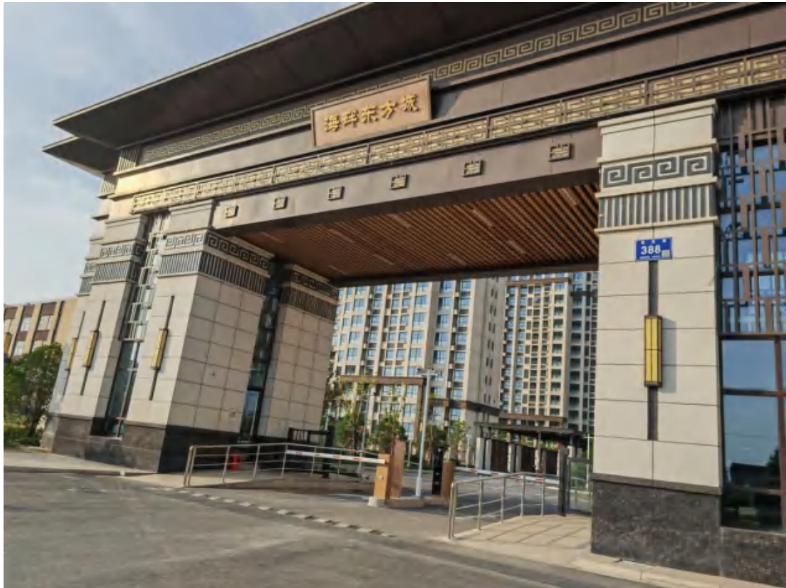
本项目完工后现场照片
