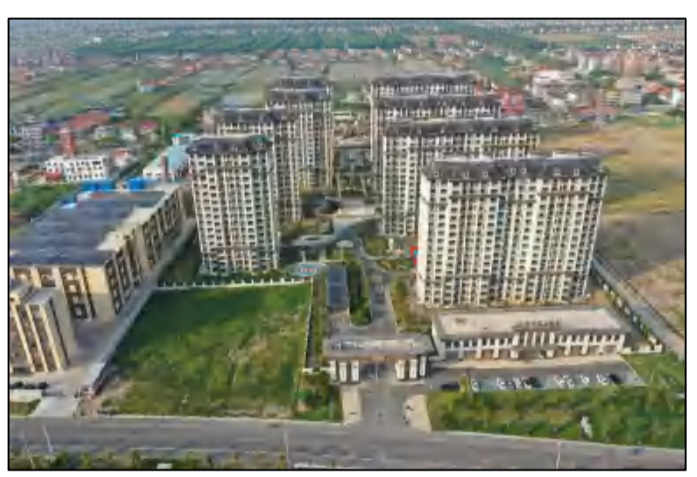
建筑物区和施工生产生活区现状
