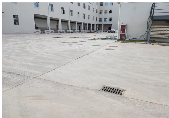
图 1-2 场地内排水设施
