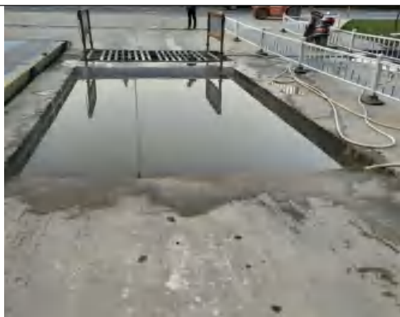
东北角出入口洗车平台 (2020.06)
