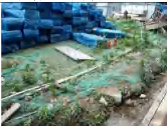
施工场地防尘网苫盖 (2020.06)
