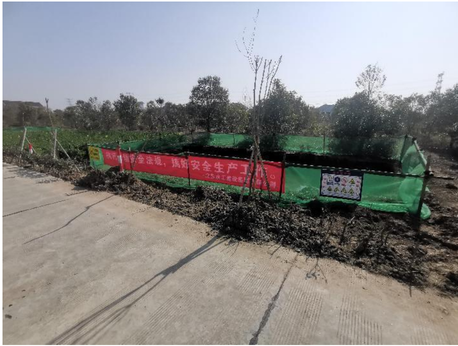
图 7-1 弃土区临时围挡
