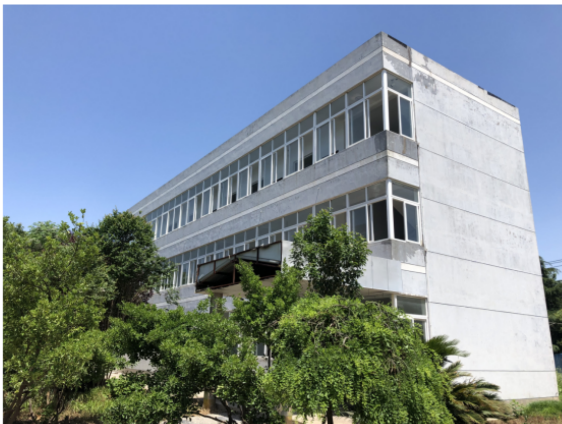
图3.3-4 原南通天源生物制品有限公司生产车间2（现为办公楼）
