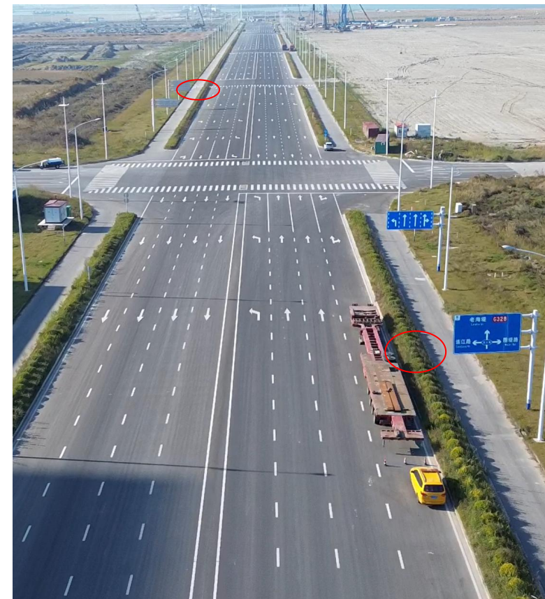
设施位置在东港南路与径三路交叉口东西方向，设施取电从交叉口位置相变取电。
