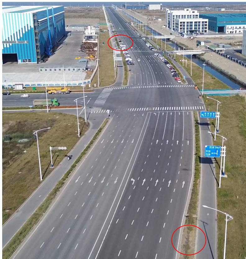
设施位置在东港东路与东港南路交叉口南北方向，设施取电从交叉口位置相变取电。
